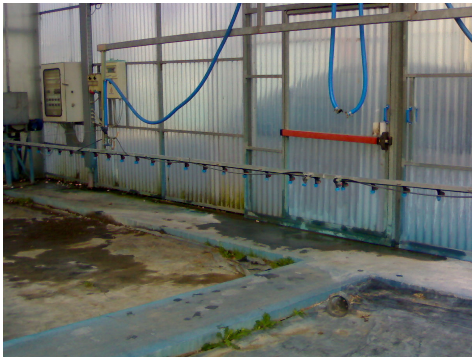
Fig. 28.1 – Barra irroratrice per l’adacquamento e l’irrorazione antiparassitaria in vivaio
