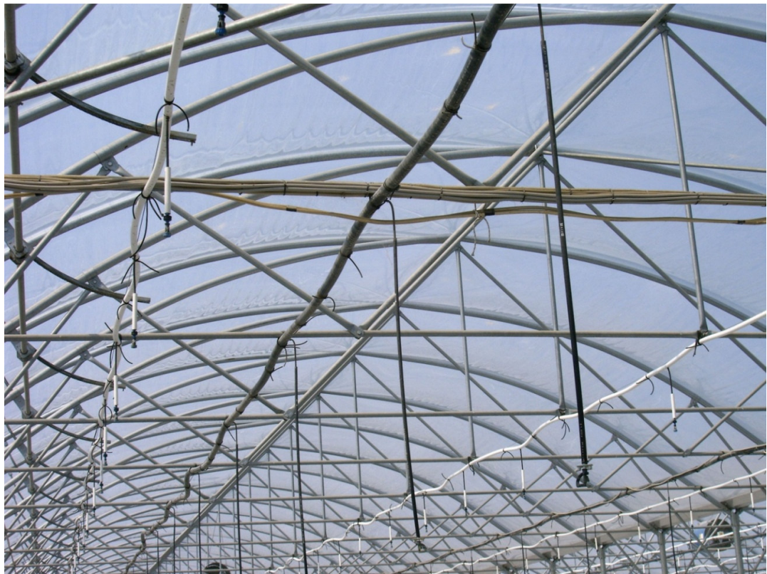
Figura 27.1 – Impianto fisso automatizzato: sono visibili le calate del sistema di distribuzione dei fitofarmaci (bianco) e dell'impianto di irrigazione (nero)
